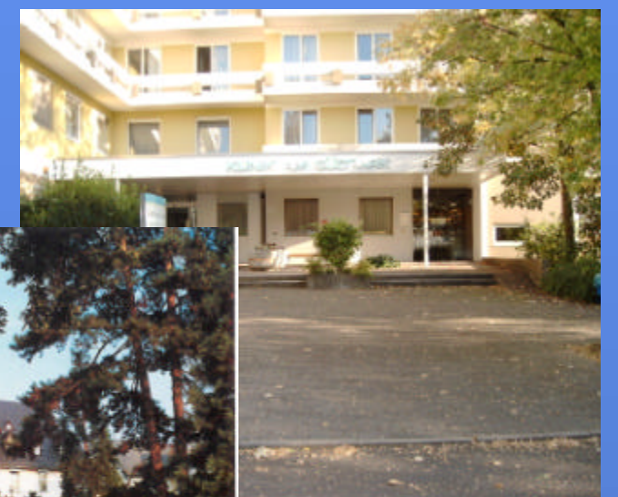
Südpark Hospital in Bad Nauheim
